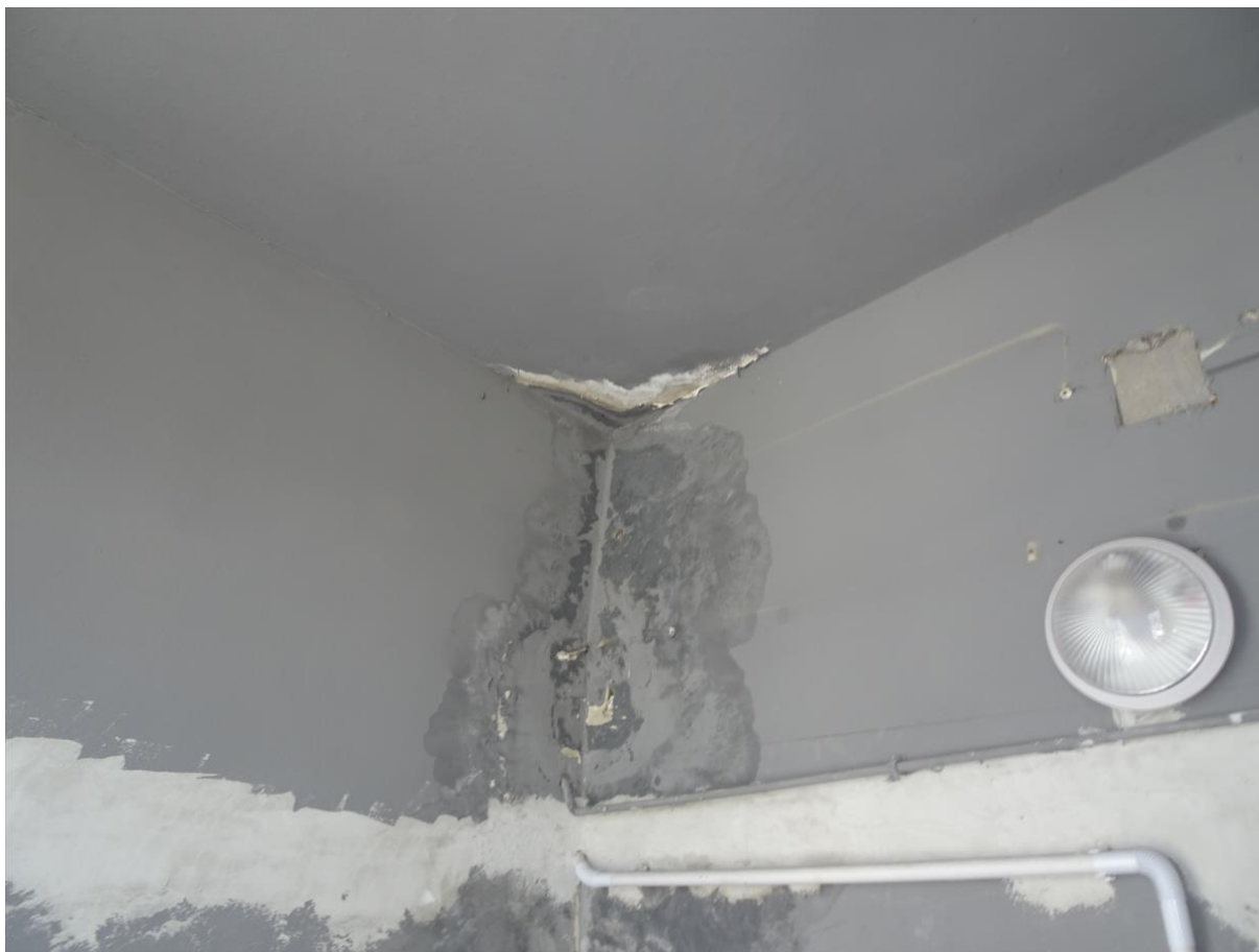
Fot. nr 24. Ślady zawilgocenia na ścianach klatki schodowej [1.3.Błąd! Nie można odnaleźć źródła odwołania.]
