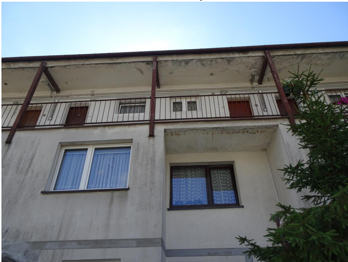
Fot. nr 18. Ślady korozji zbrojenia na spodzie płyty galerii. Widoczne zabrudzenia elewacji [1.3.Błąd! Nie można odnaleźć źródła odwołania.]
