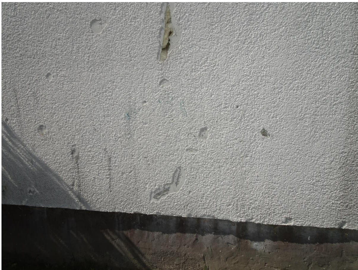
Fot. nr 19. Lokalne uszkodzenia warstwy ocieplenia na ścianie szczytowej – uszkodzenia materiału izolacyjnego, ubytki wyprawy tynkarskiej [1.3.Błąd! Nie można odnaleźć źródła odwołania.]
