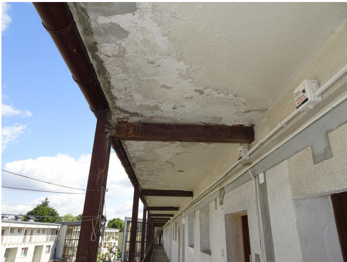
Fot. nr 14. Sufit galerii – ślady zawilgocenia na powierzchni sufitu, odspojenia tynków i powłok malarskich, lokalna korozja konstrukcji stalowej zadaszzenia [1.3.Błąd! Nie można odnaleźć źródła o dwołania.]
