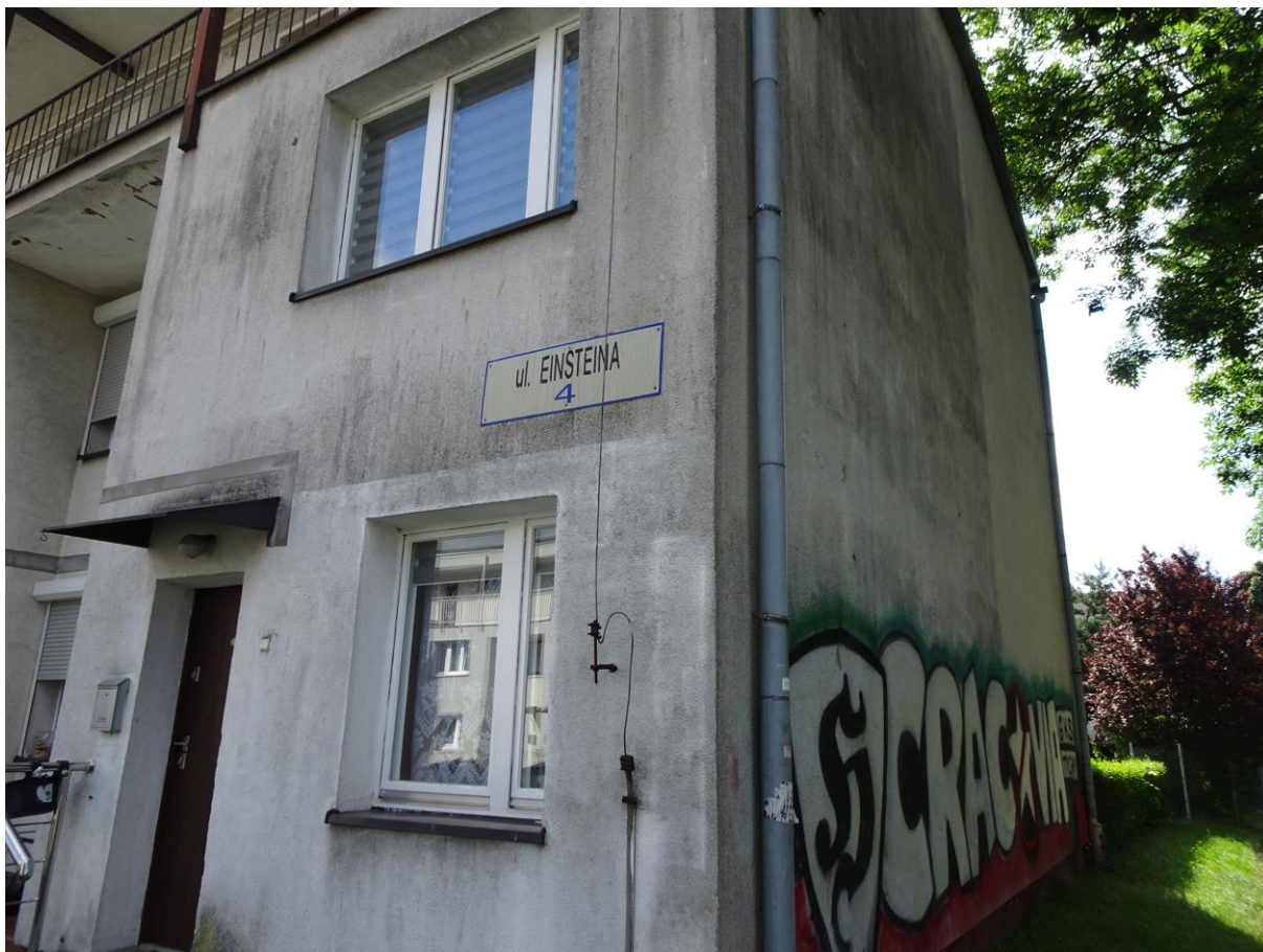
Fot. nr 10. Zabrudzenie elewacji, ślady zawilgocenia przy cokole budynku [1.3.Błąd! Nie można odnaleźć źródła odwołania.]
