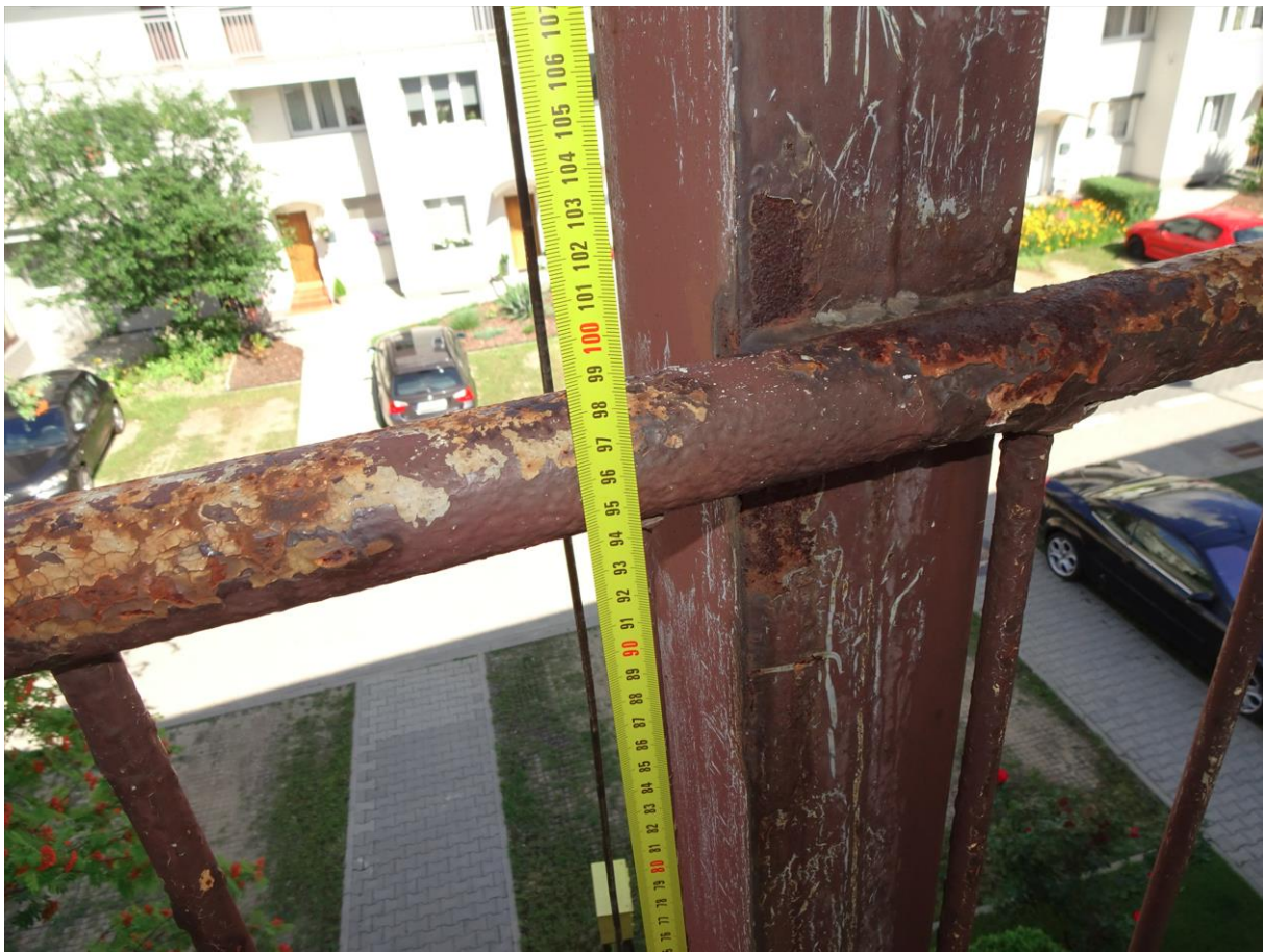
Fot. nr 16. Balustrada galerii – korozja stalowych elementów balustrady i słupów zadaszenia. Pomiar wysokości balustrady – wynik poniżej 110 cm [1.3.Błąd! Nie można odnaleźć źródła odwołania.]
