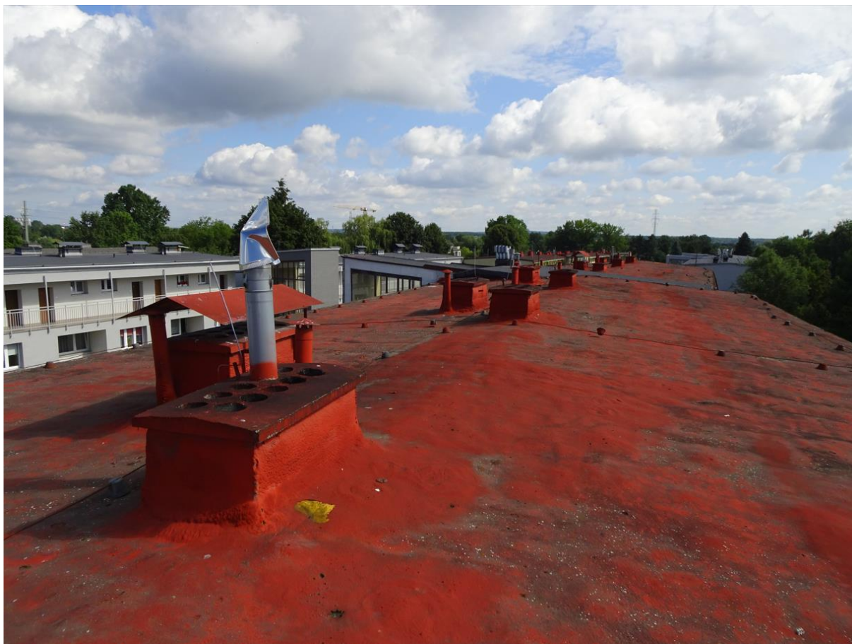
Fot. nr 21. Ogólny widok pokrycia dachowego z pianki poliuretanowej – brak płaszczyznowości pokrycia, lokalne ubytki warstwy pokrycia dachowego i odsłonięcie materiału izolacyjnego [1.3.Błąd! Nie można odnaleźć źródła odwołania.]
