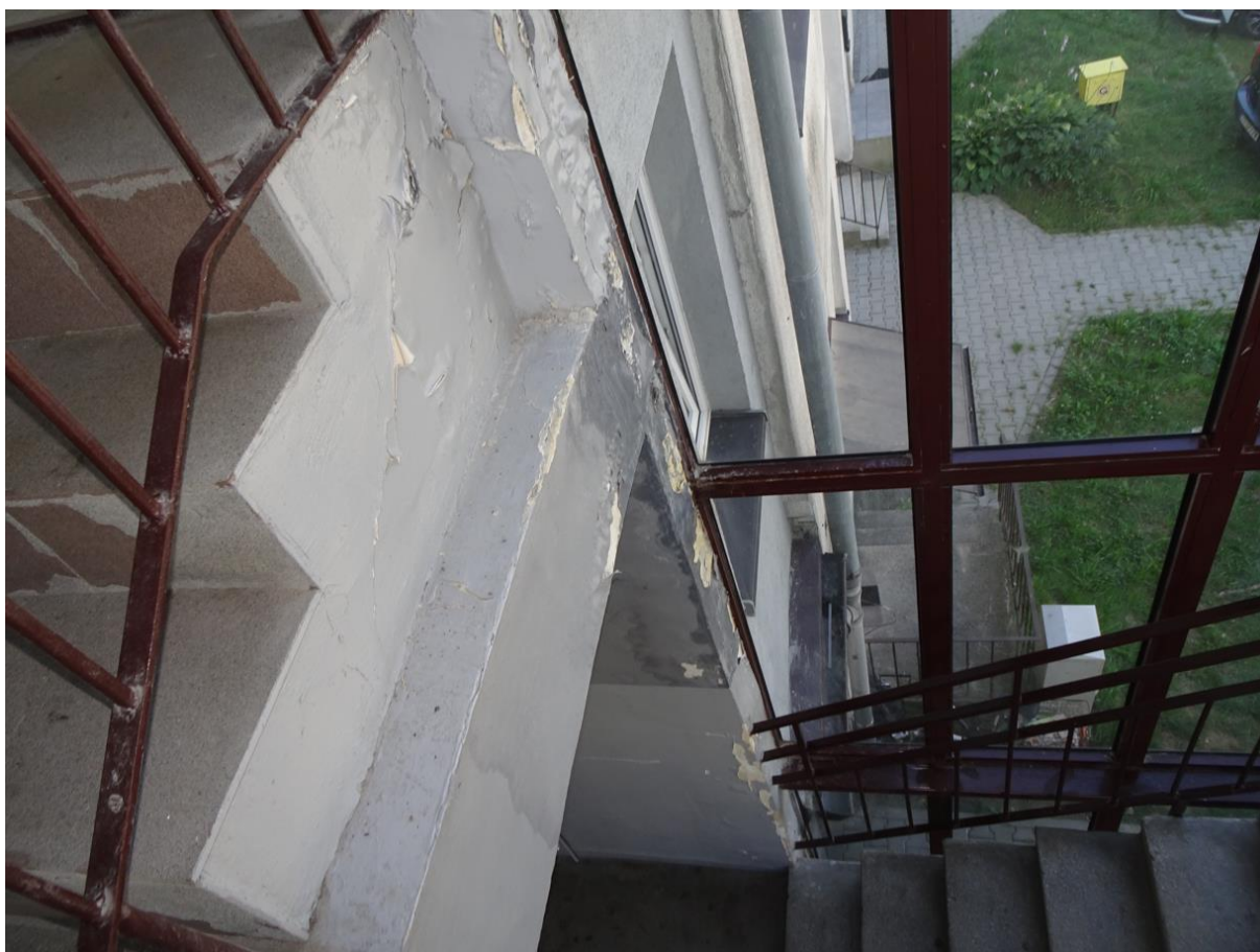
Fot. nr 25. Destrukcja (zawilgocenia, odspojenie) tynków ścian klatki schodowej wzdłuż ram okien klatki schodowej [1.3.Błąd! Nie można odnaleźć źródła odwołania.]
