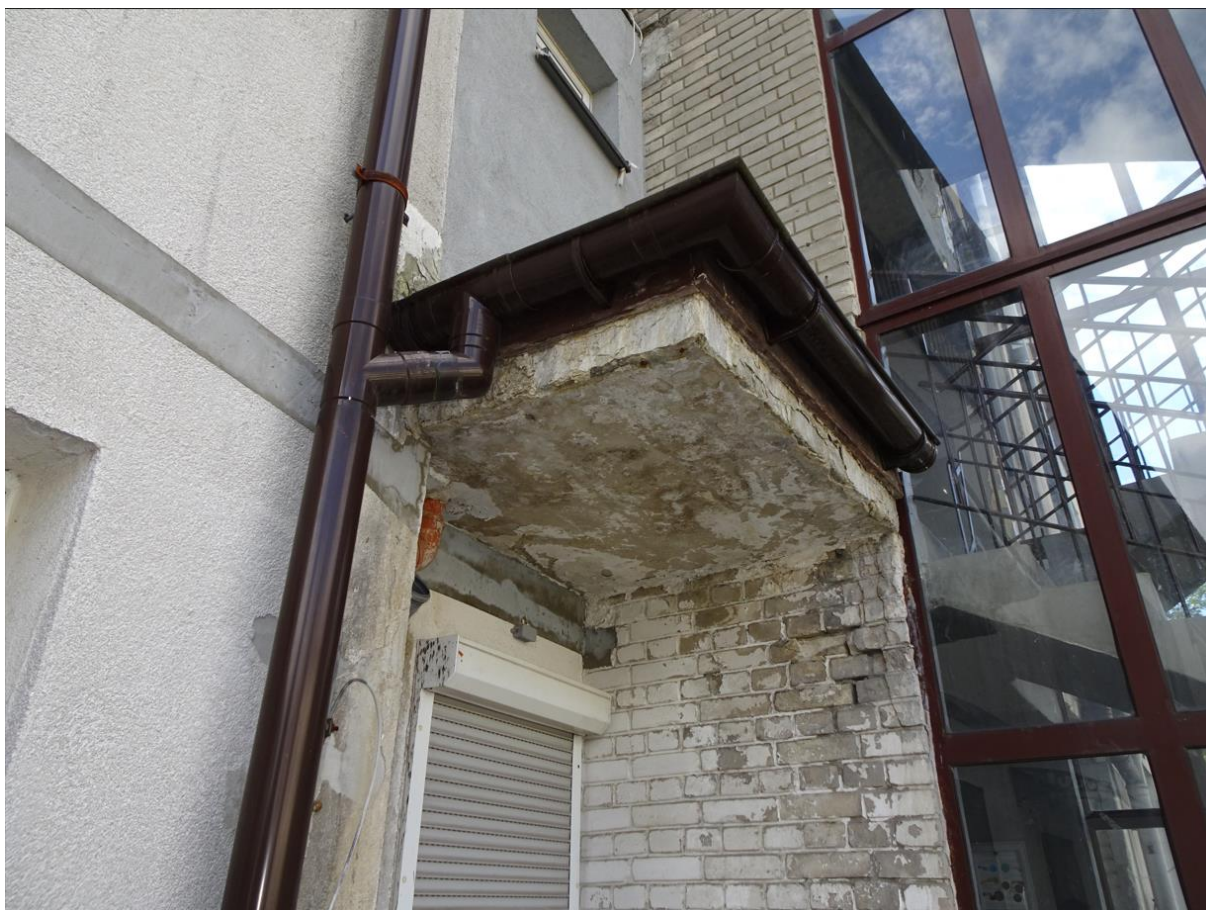
Fot. nr 11. Zadaszenie przy budynku – widoczne ślady zawilgocenia na spodzie zadaszenia [1.3.Błąd! Nie można odnaleźć źródła odwołania.]
