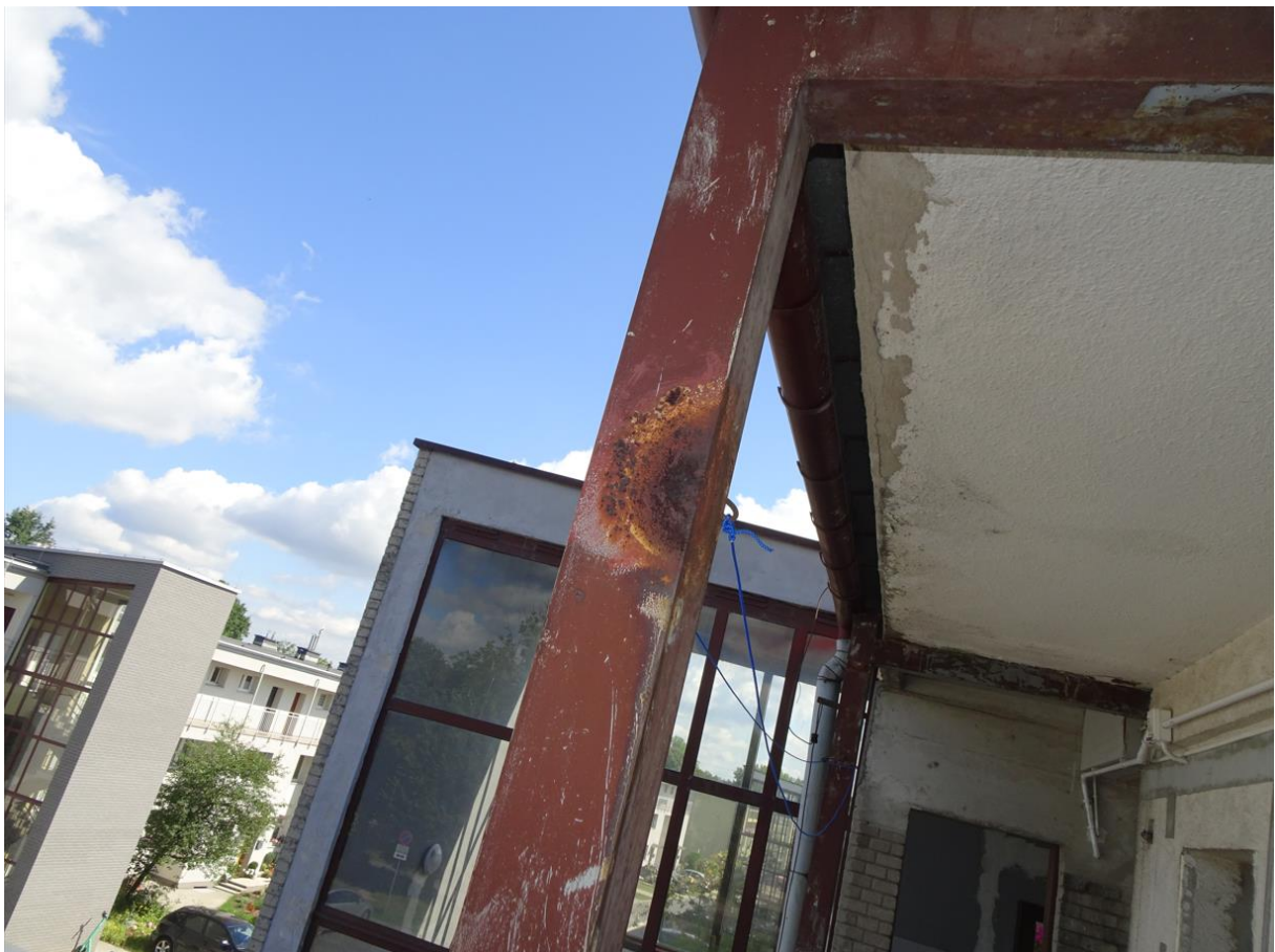
Fot. nr 13. Miejscowa korozja konstrukcji stalowej galerii [1.3.Błąd! Nie można odnaleźć źródła odwołania.]
