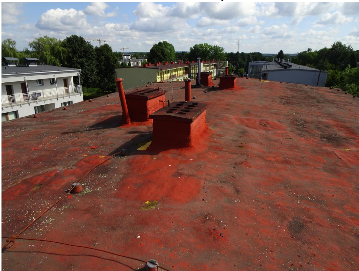
Fot. nr 21. Ogólny widok pokrycia dachowego z pianki poliuretanowej – brak płaszczyznowości pokrycia, lokalne ubytki warstwy pokrycia dachowego i odsłonięcie materiału izolacyjnego [1.3.Błąd! Nie można odnaleźć źródła odwołania.]
