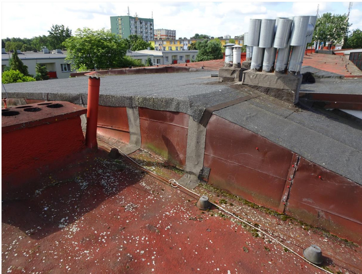
Fot. nr 23. Pokrycie dachowe na połączeniu segmentu mieszkalnego z klatką schodową – ślady zawilgocenia obróbek blacharskich [1.3.Błąd! Nie można odnaleźć źródła odwołania.]
