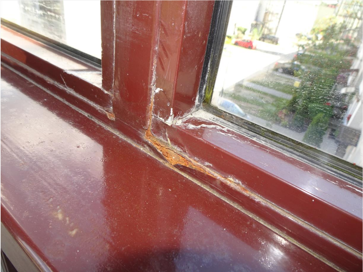
Fot. nr 26. Korozja ram okiennych okien klatki schodowej, widoczne ślady zalewania ram okiennych oraz glony na uszczelce okiennej [1.3.Błąd! Nie można odnaleźć źródła odwołania.]
