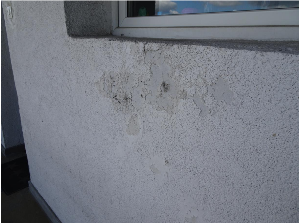
Fot. nr 12. Miejscowe ubytki wyprawy tynkarskiej na ścianach galerii [1.3.Błąd! Nie można odnaleźć źródła odwołania.]
