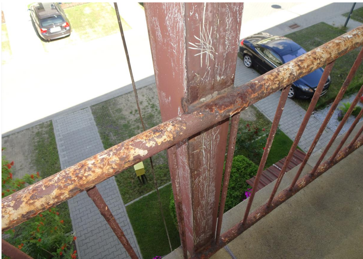
Fot. nr 15. Balustrada galerii – korozja stalowych elementów balustrady [1.3.Błąd! Nie można odnaleźć źródła odwołania.]
